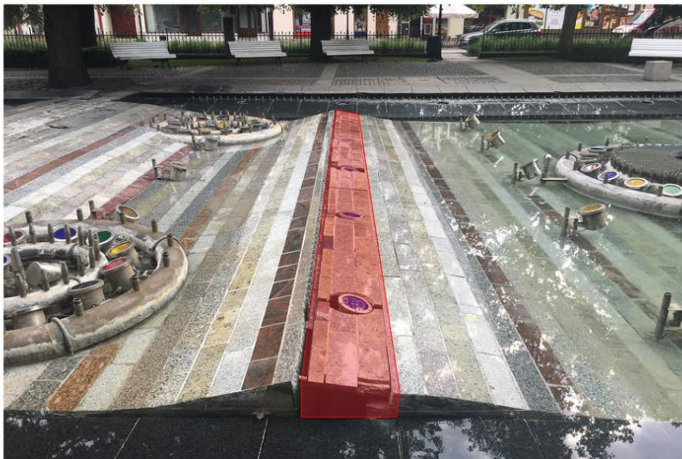
vymeniť segmenty s chýbajúcimi a popraskanými kachličkami
